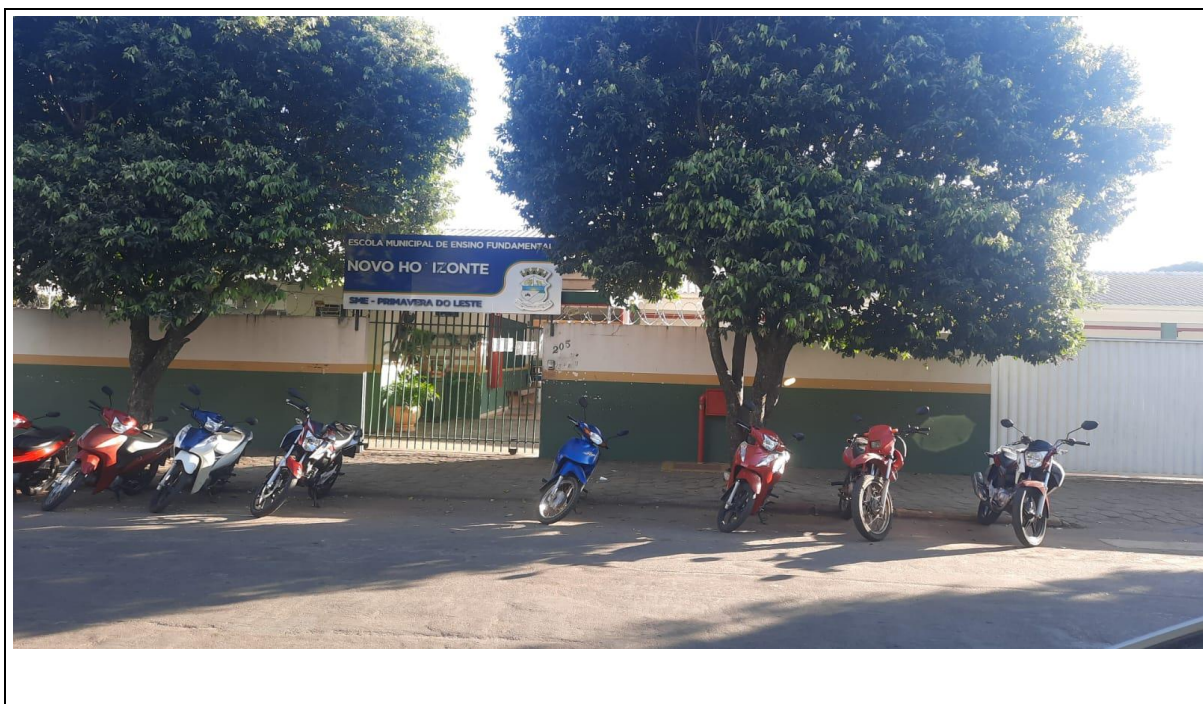
Figura 1- Fachada da Escola Municipal de Ensino Fundamental Novo Horizonte – Primavera do Leste-MT
